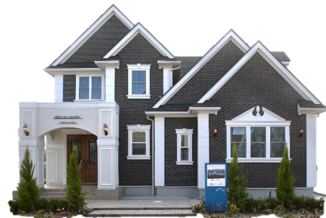
※「カンバーランド」施工事例
